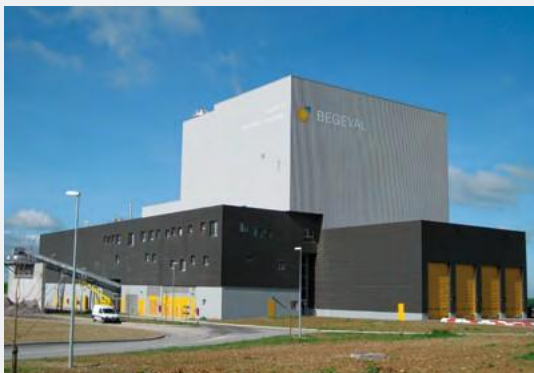
▲ L'usine d'incinération de Pithiviers est gérée par le syndicat Beauce Gâtinais Valorisation (BGV)
